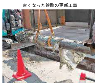
古くなった管路の更新工事
