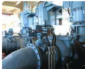
更新時期を迎える水道施設
